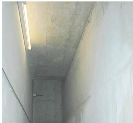
Der Blick in den mehr als 90 Meter langen Erdkanal zur Klimatisierung der Schweinfurter Büroräume mittels Erdwärme und -kühle.
